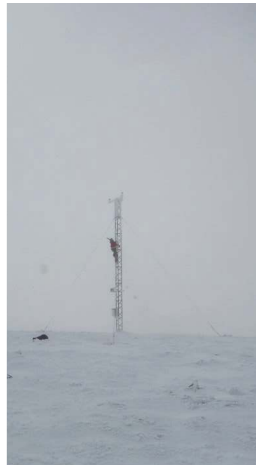
Entretien de la station météo aux Mines Madeleine.
